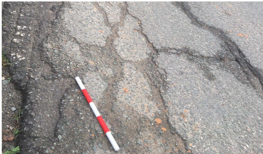
Gambar 3. Retak Kulit Buaya
