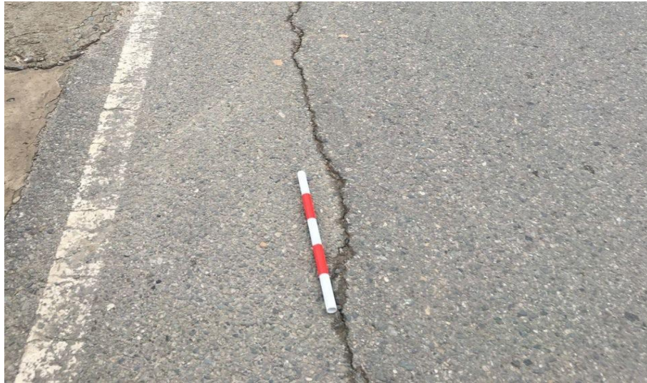
Gambar 4. Retak Pinggir
